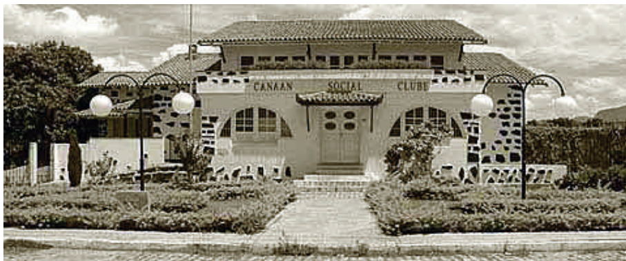
Fotografia 10 - Canaan Social Clube reformado: características originais foram conservadas.
